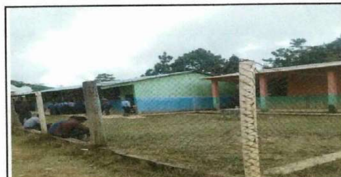
Foto 6: La malla que rodea el establecimiento se ha deteriorado hasta tener agujeros que vuelven inseguro el espacio.
